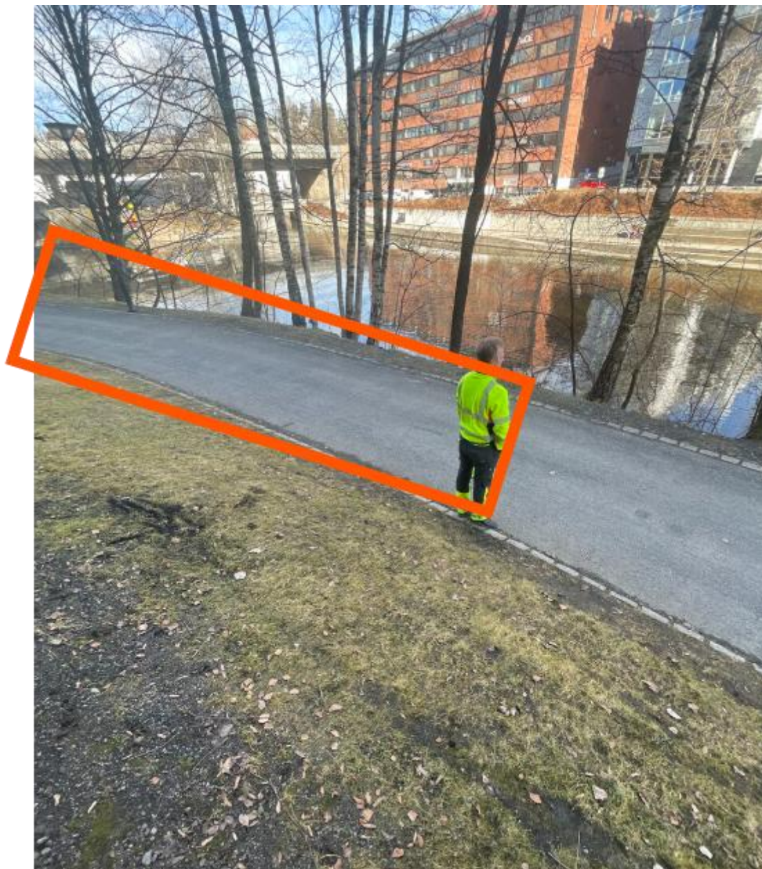
Figur 3 Startpunkt for åpen graving langs gangveien ved Sandvikselva. Gravingen vil foregå tett inntil trær med betydelige rotsystemer, og det er derfor krav om arboristbistand i denne sonen. For å redusere skadeomfanget er det planlagt bruk av spunting i grøfta for å sikre vertikale sider, som minimerer behovet for bred avgraving og dermed beskytter røtter og tilstøtende vegetasjon.
